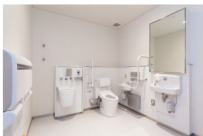
▲多目的トイレ (長浜消防署)
